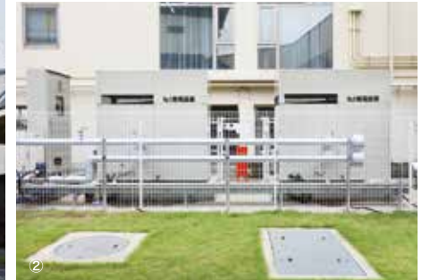
① LNGの貯蔵施設。LNGは重油と比べて二酸化炭素排出量が少ない ② バイオガスソージェネレーションシステム。夏冬の電力不足時の電力供給にも貢献する
