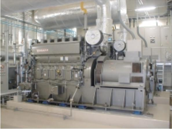
関東工場では、コージェネレーションシステムを導入いたしました。導入した設備は、重油を燃料とするエンジンを廻して発電を行う一方、運転中に排出される廃熱を利用し、廃熱ボイラーの運転を行っております。これにより、エネルギーの有効利用、CO<sub>2</sub>排出量の削減に寄与しております。引き続き、他工場への展開を検討してまいります。
